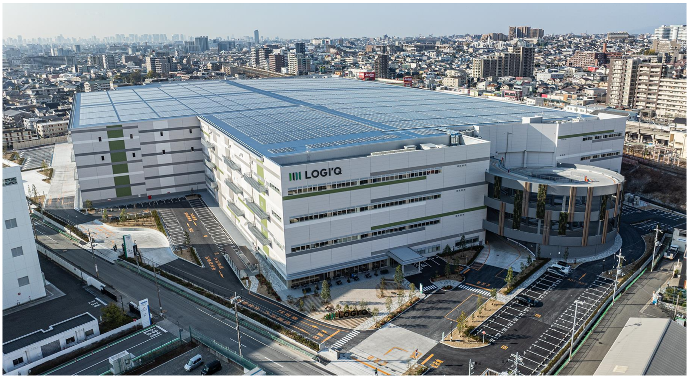
当社オンサイトPPAを行うリエネLOGI'Q南茨木太陽光発電所
