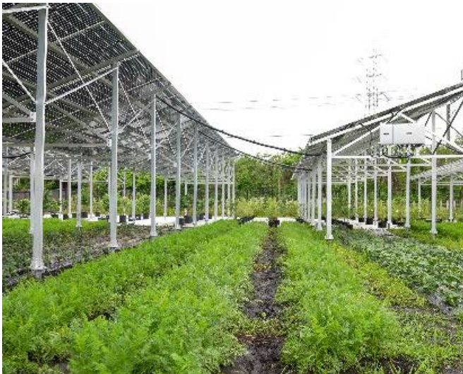
リエネソーラーファーム東松山太陽光発電所
