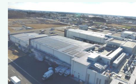
リエネ栃木芳賀太陽光発電所
