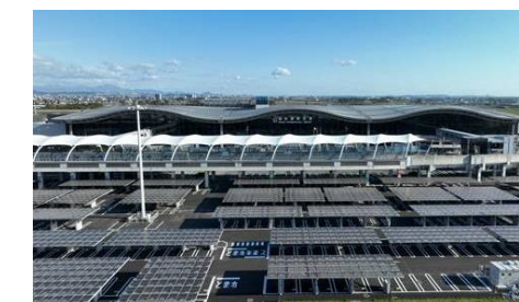
仙台空港ソーラーカーポート発電所
