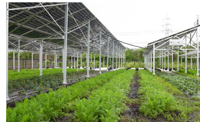
リエネソーラーファーム東松山太陽光発電所
