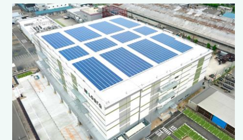
リエネLOGI'Q京都久御山太陽光発電所
